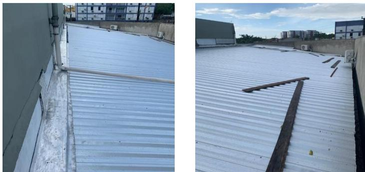
As altas temperatura acumuladas entre a cobertura e o forro, criou um ambiente úmido e quente na Hemodinâmica, por consequência disso, água condensava constantemente nas paredes atingindo o Angiógrafo, RPA e diversos outros ambientes. Por esse motivo, urgiu a necessidade da troca das telhas de fibrocimento por telhas térmicas sanduíches para conter essa alta umidade acumulada acima do forro, sanando esta umidade por condensação.
