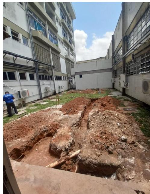
*Escavação manual do terreno para mudança de caixas de esgoto e remanejamento de circuitos enterrados.*
