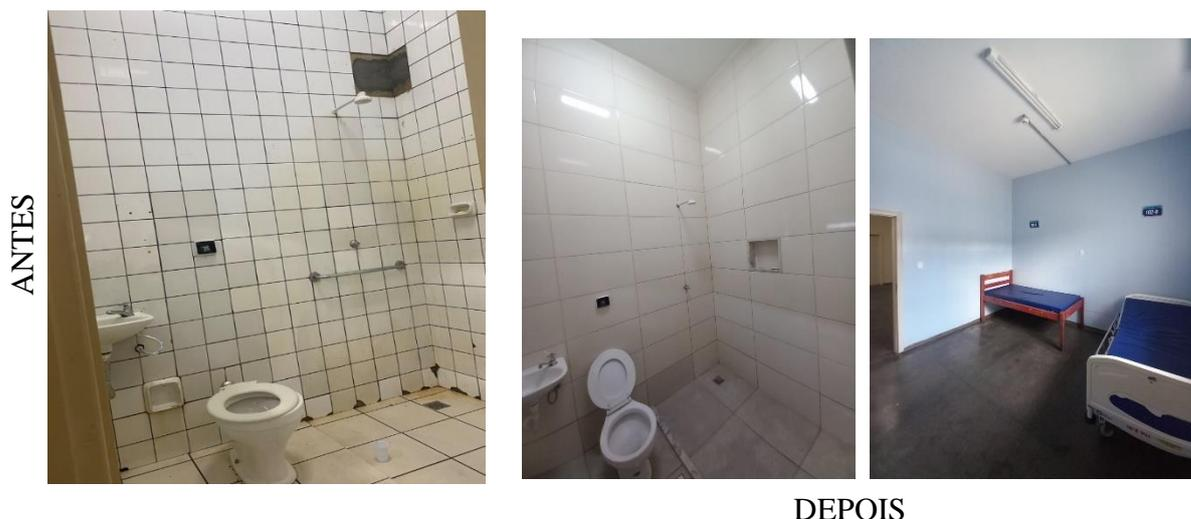
Os serviços contaram com a quebra da cerâmica de parede, instalação de novos acessórios hidráulicos (ralo, chuveiro, nicho, vaso), assentamento de nova cerâmica e lajota no banheiro e revitalização de parede e teto da Enfermaria Infanto Masculino.
