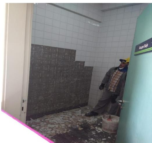
*Retirada de revestimentos cerâmicos para adequar o novo DML da Clínica Cirúrgica*
